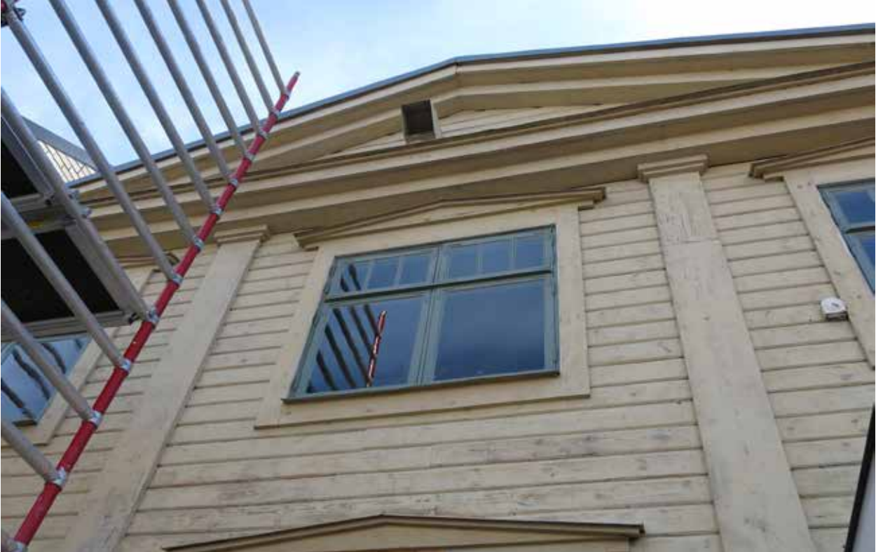
Huvudfasad, underarbetet med slipningen är avslutat.
