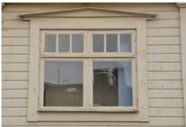
Övervåning, vänstra fönstret
