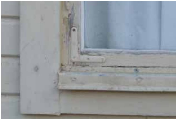
Moderna 5-håls hörnjärn ersattes med 4-håls hörnjärn.
