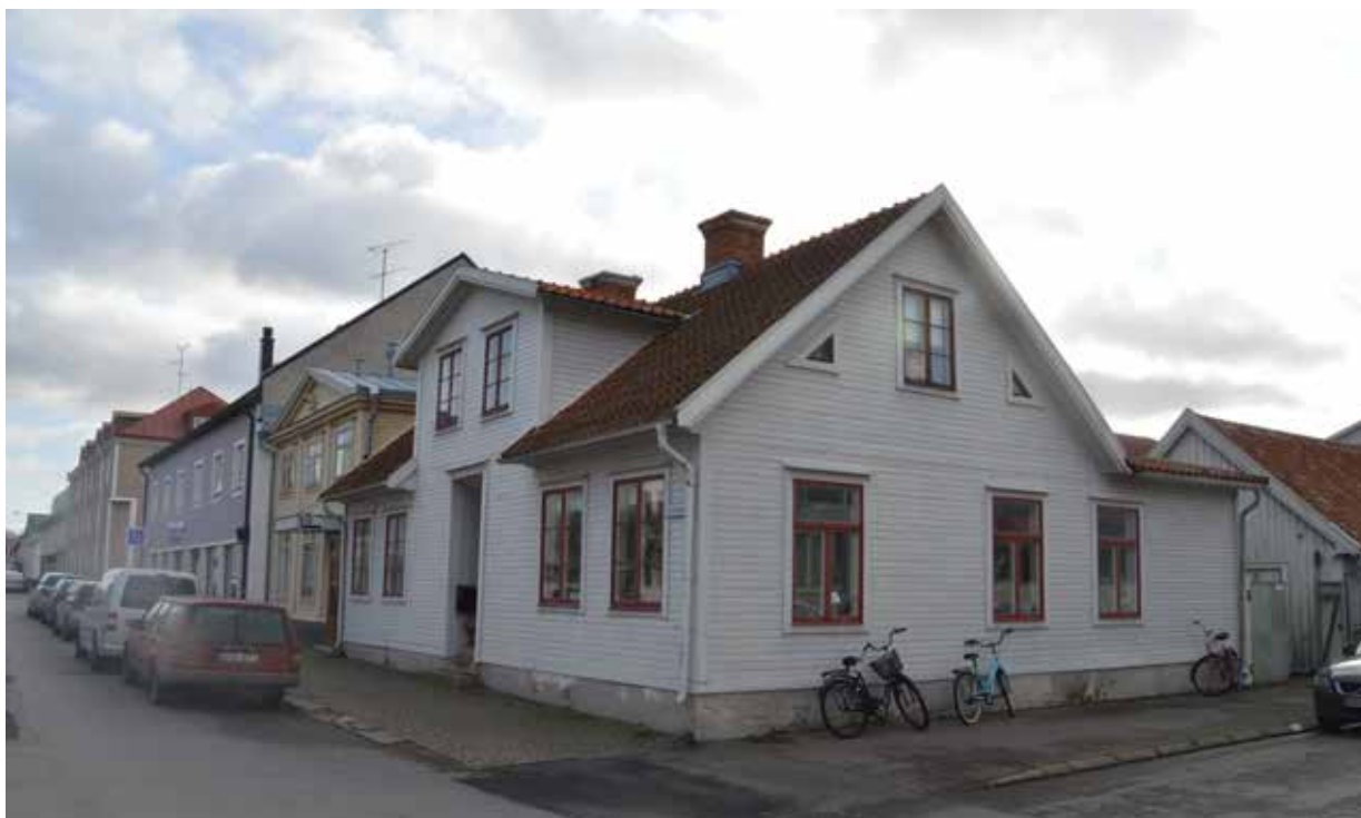
Fastighet Kamelen 1 sett från nordväst.
