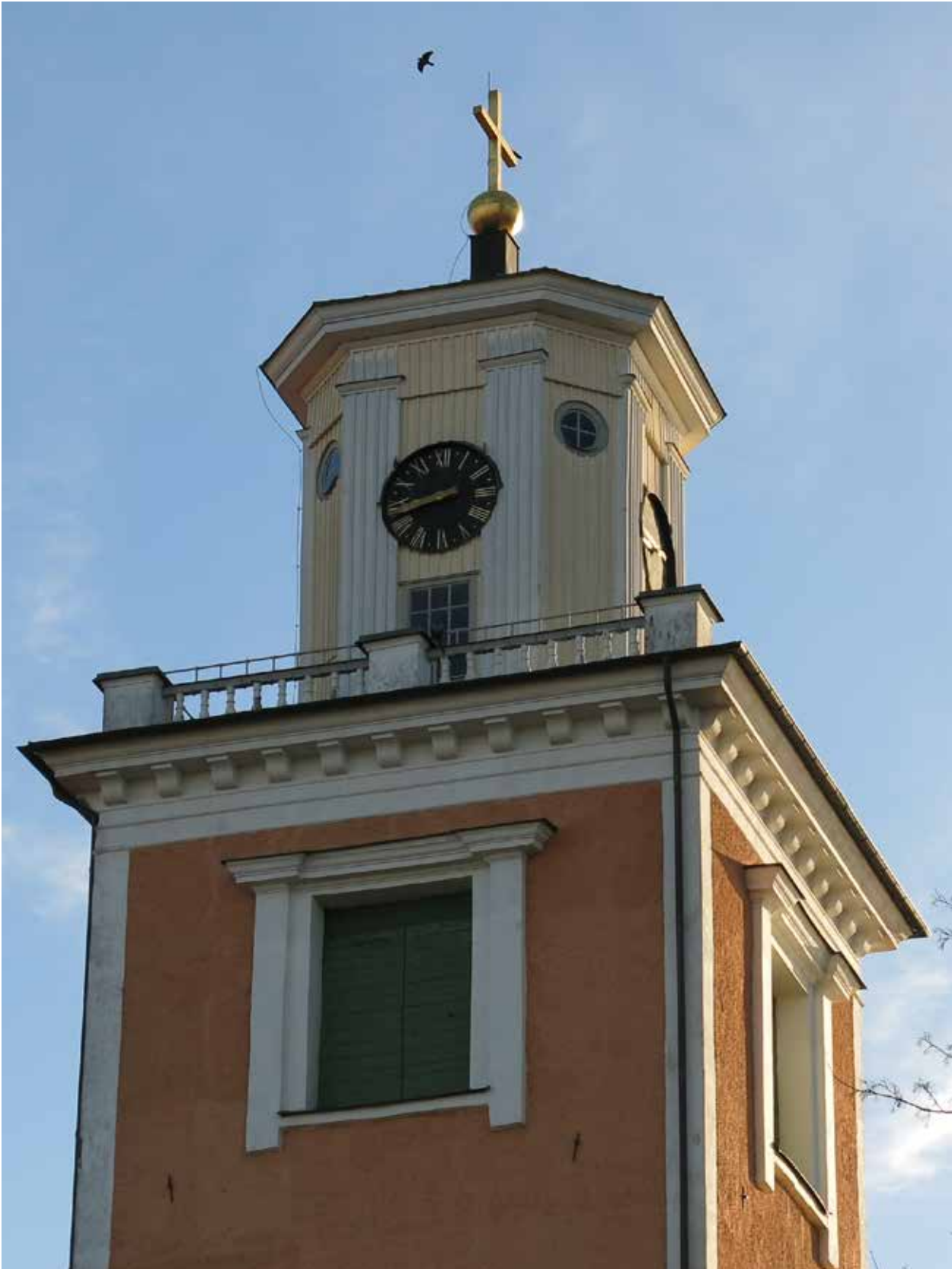
Lanterninen före renoveringen
