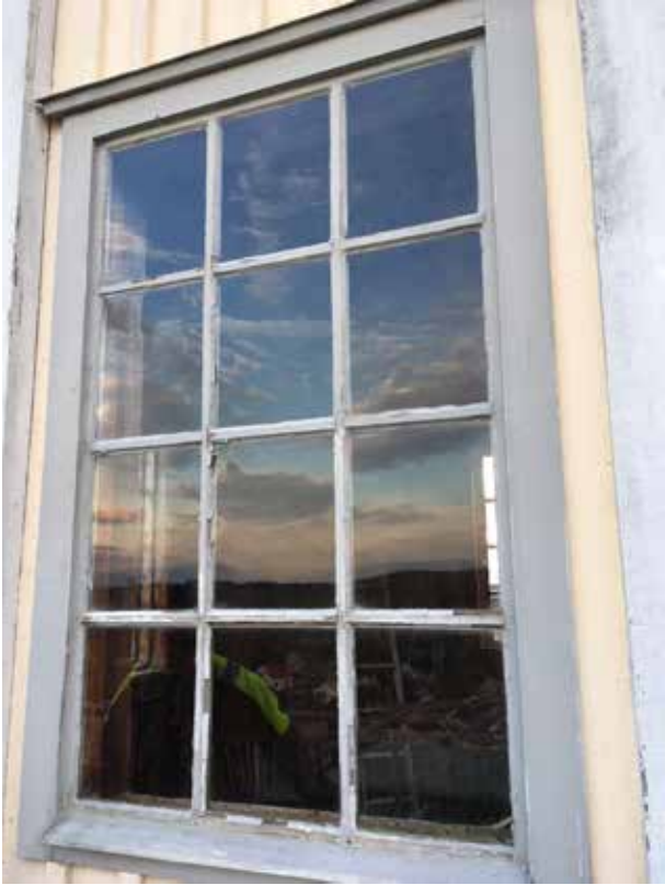
Fönstren före renoveringen
