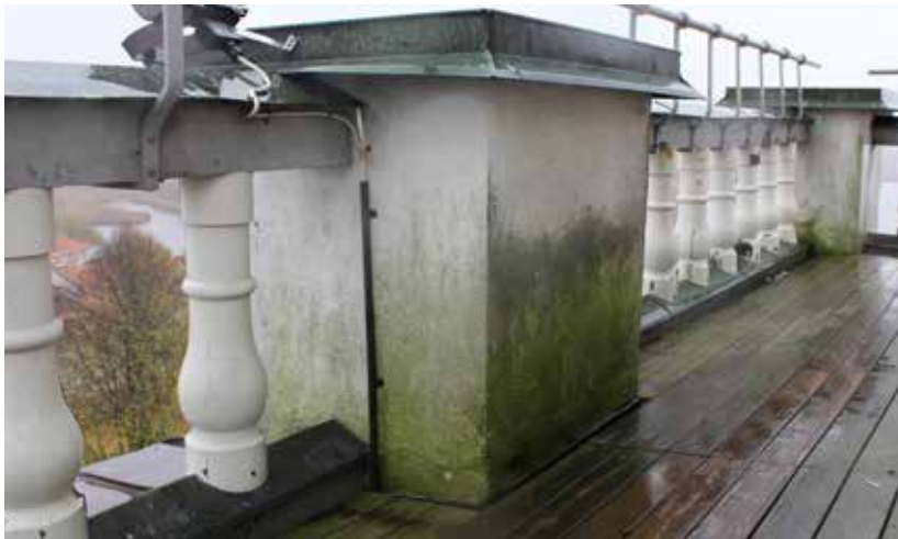
Balustraden före reoveringen
