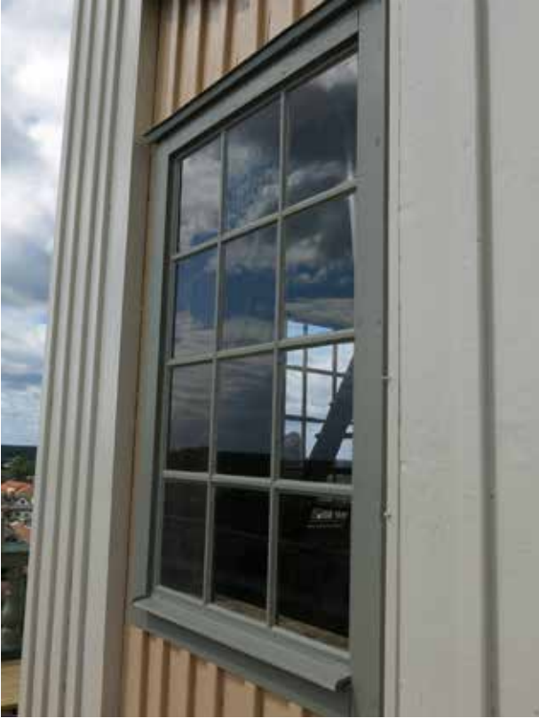
Fönstren efter renoveringen
