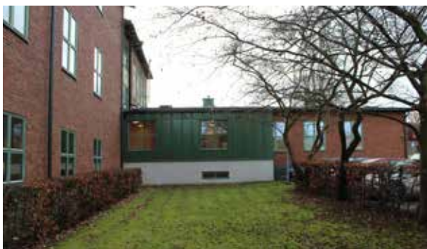
Tillbyggnad i grön plåt i hörnet mellan gymnastiksalen och vinkelbyggnaden.
