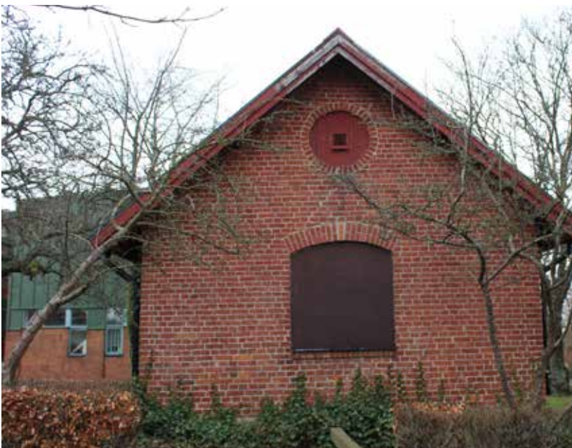
Igensatt segmentbåigt fönster.
