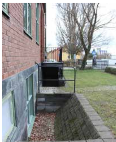
Ljusschakt framför suterrängfönstret.
