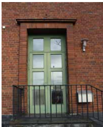
Dörr med tegelomfattning och kopparavtäckning.
