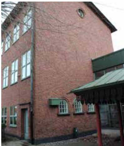
Spröjsade fönster med avtäckning i koppar och fönsterbänk i skiffer
