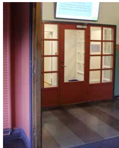
Modernt dörrparti mellan vestibul och vinkelbyggnaden.
