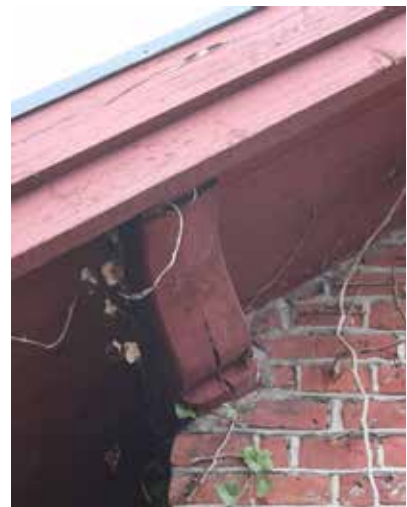
Nätt takutsprång och profilerade taktassar.
