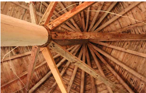
Mittpelare med strävor stöder upp tälttak.
