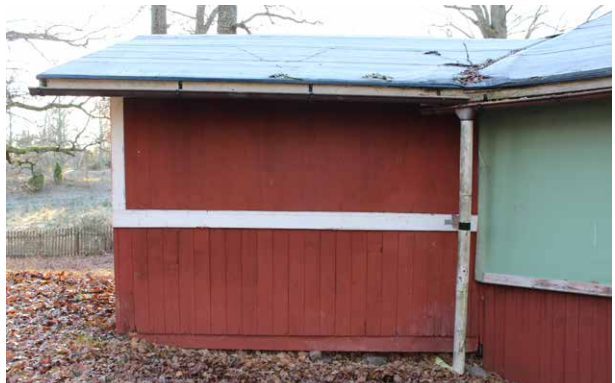
N-fasad: fasspont. Över räcket slätspont.
