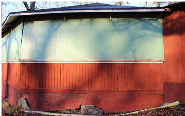
Hörnstenar av granit. Plywoodskivor, fäst med gångjärn i syllen.
