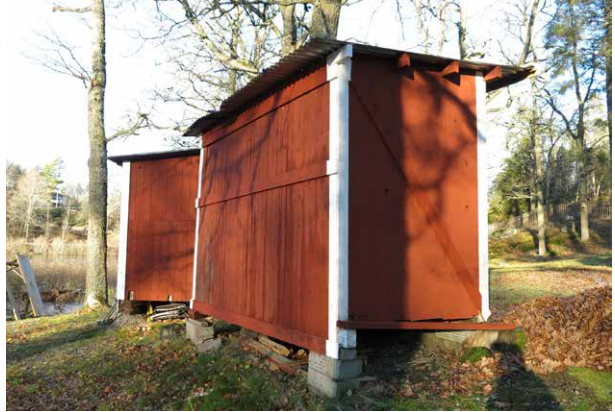
Fundament av staplade betongstenar
