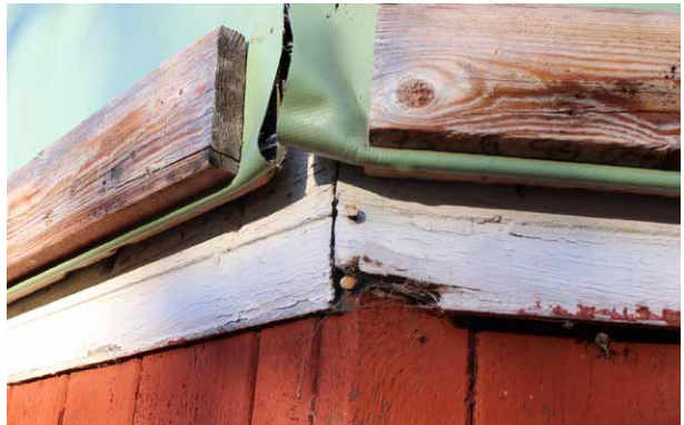
Fasaderna 1 till 4 är fortfarande klädd med den ursprungliga smala faspanelen.
