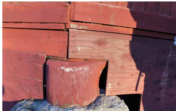
Fundament av stubbar och granitsten.
