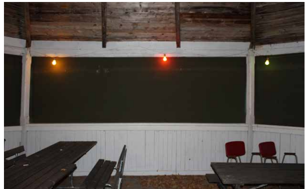
Stolpkonstruktion med profilerade stolpar, överliggare och bröstningar.
