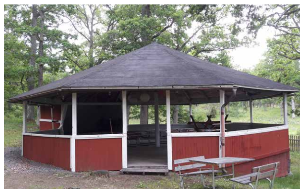
N fasad med ingången. Stolpar, öppna fönsterrader och bröstningar. Foto: Lst 2017.
