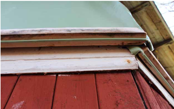
Bröstningsfoder med smäckra profileringar på fasad 1 till 4..
