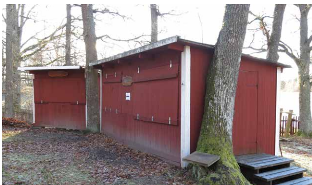
Ingång med trappa på norra sidan.
