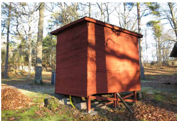
Underreda av regler och brädor
