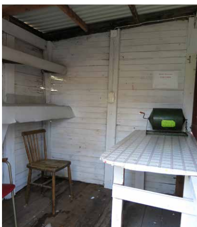
Stolpkonstruktion med kraftiga stolpar. Enkel inredning med hyllor och bord.
