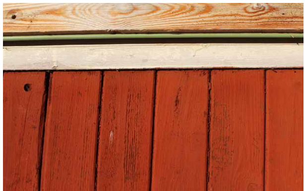
Fasaderna 1 till 4 är fortfarande klädd med den ursprungliga smala faspanelen.
