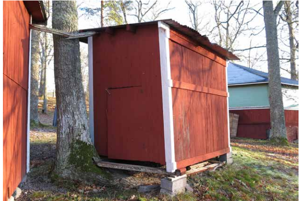
Fundament av staplade betongstenar
