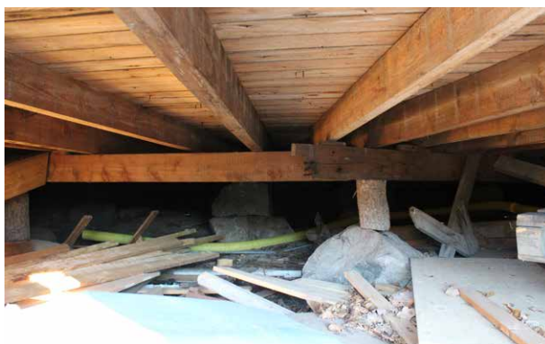
Golvbjälklag i radial anordning. Vilar på stubbar och stenar.
