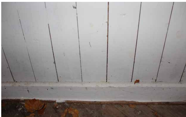
Bröstningarna ( fack 1 till 4) är på insidan klädd med spontad 1" panel.
