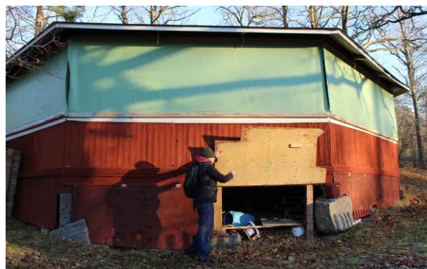
Uppfällningsbara luckor. Extra stödpelare under syllstocken.
