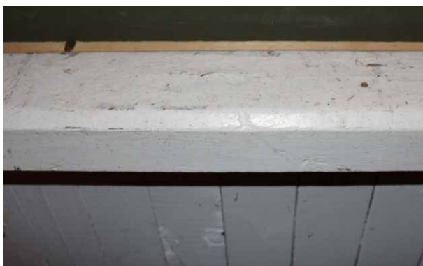
Bröstningen i fack 5 till 7 är inte ursprunglig. Överliggare av kraftig, avfasad regel.
