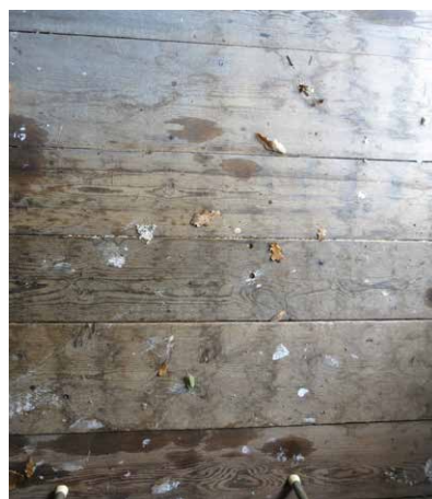
Plankgolv, fallande bredder.
