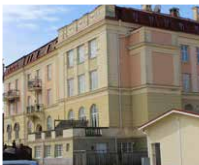
Norra risaliten förr och efter ombyggnad till lägenheter. Ritning: Originalritning 1909, Sölvesborg kommunarkiv.
